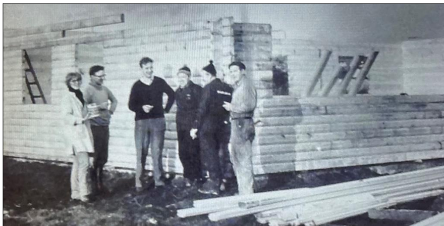
Byggeriet er i gang.
